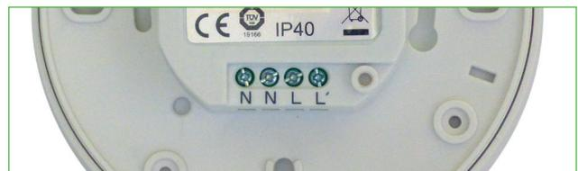
Bornas para la conexión del cableado.
